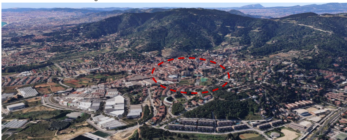
Figura 3. Vista en 3D de l'àmbit des del nord-est. Street View.
