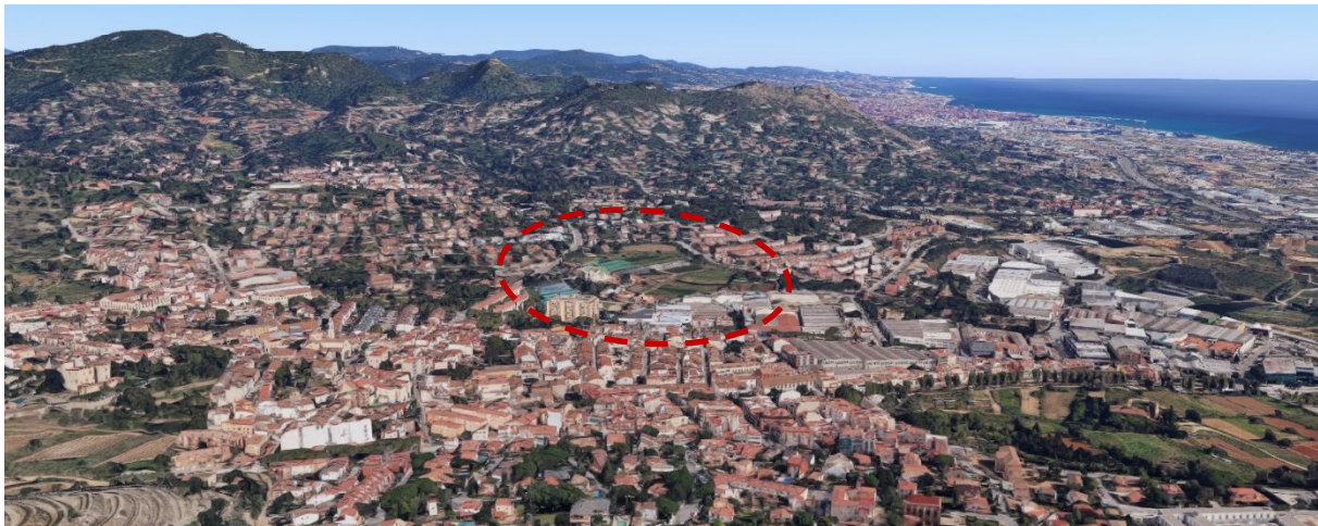
Figura 2. Vista en 3D de l'àmbit des del sud-oest. Street View .
