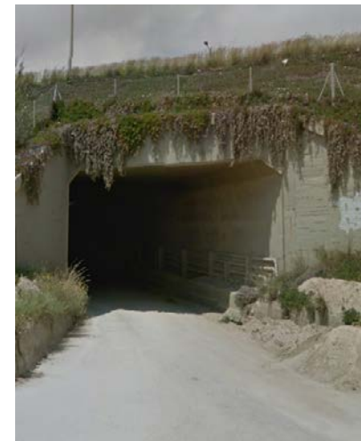
Pas soterrat C-32
